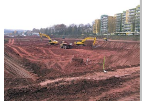
Schweres Gerät durchwühlt die rote Erde: Im Jahr 2003 wurde mit den Rohbauarbeiten begonnen.
